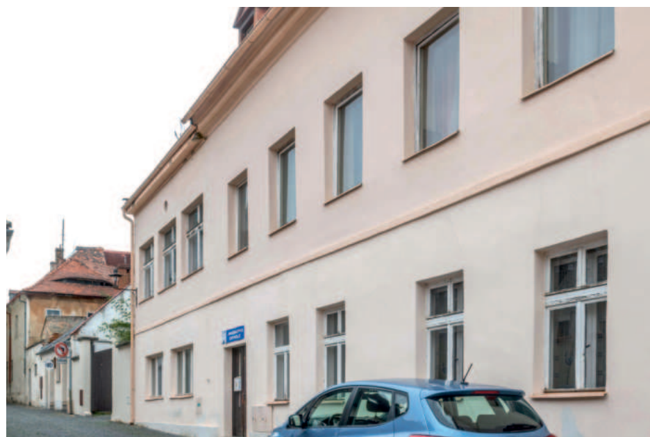
pohled z Panské ulice - původní stav
